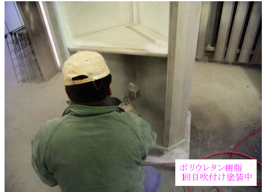
直営 青木様所有コーナーボード ポリウレタン樹脂 1回目吹付け中 2010年2月20日
