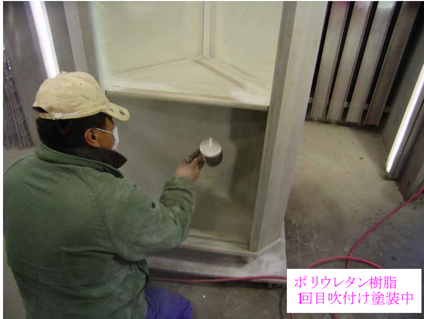
直営 青木様所有コーナーボード ポリウレタン樹脂 1回目吹付け 2010年2月20日
