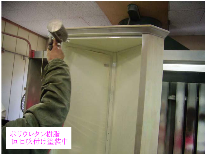
直営 青木様所有コーナーボード ポリウレタン樹脂 1回目吹付け中 2010年2月20日
