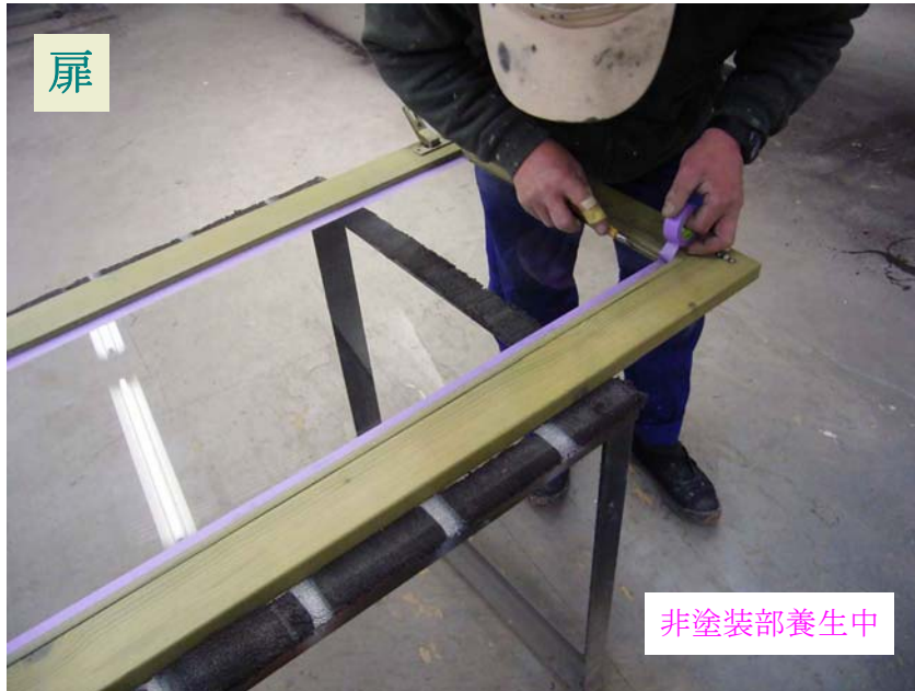
直営 青木様所有コナホート 非塗装部養生中/後、金具取り外し中 2010年2月16日
