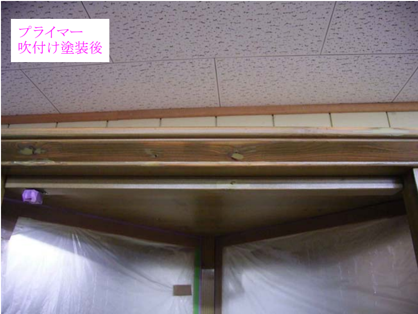
直営 青木様所有コーナポード プライマー吹付け後 2010年2月19日
