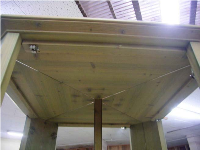
直営 青木様所有コーポレート 施工前 2010年2月16日
