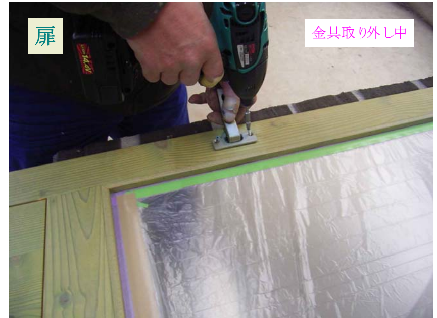
直営 青木様所有コナホート 非塗装部養生中/後、金具取り外し中 2010年2月16日
