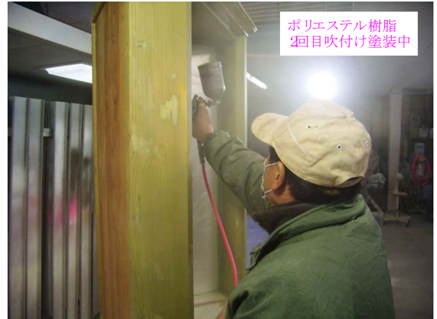
直営 青木様所有コーナーポット ポリエステル樹脂 2回目吹付け中 2010年2月19日
