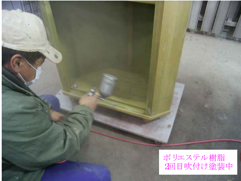
直営 青木様所有コーナート ポリエステル樹脂 2回目吹付け中 2010年2月19日
