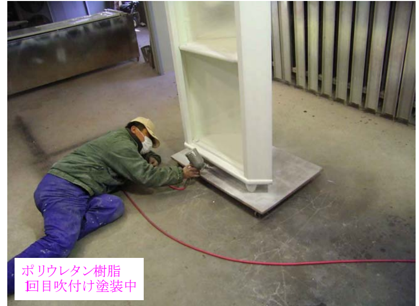
直営 青木様所有コーナーボード ポリウレタン樹脂 1回目吹付け 2010年2月20日
