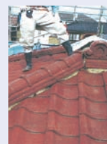
軽い屋根材への葺き替え
