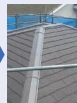
軽い屋根材への葺き替え
