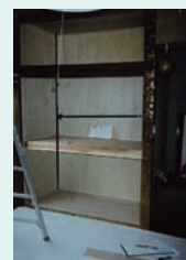
押入や室内側から筋かいや構造用合板により補強(内装仕上工事を含む)
