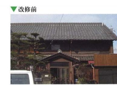
既設の日本瓦を撤去後、屋根をカラートタン葺にして軽量化
