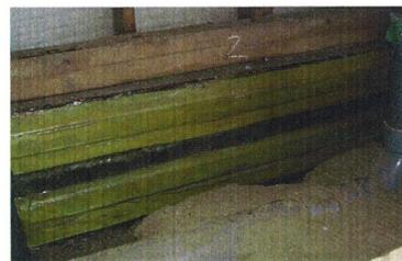
底盤を拡大する工法ではないので、基礎の沈下を止めることはできません。
