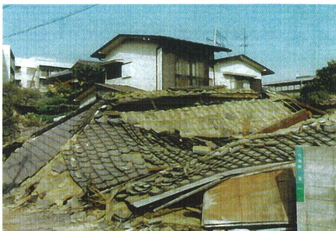
耐力不足と老朽化で完全に倒壊した住宅<sup>1)</sup>
